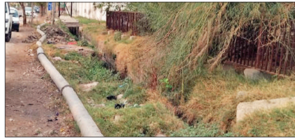
चरखी दादरी। शहर में बरसाती पानी निकासी के लिए बिछाई गई पाइप लाइन।
